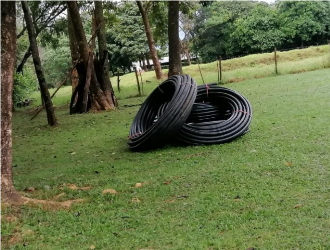
Fotografía 3. Reemplazo de redes de conducción.
