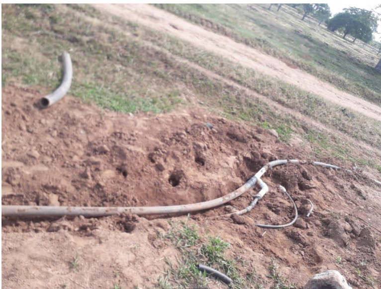
Fotografía 13. Trabajos en las redes de distribución.
