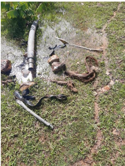
Fotografía 14. Mantenimiento de redes.
