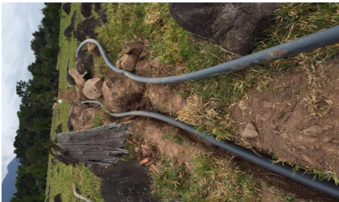
Fotografía 8. Trabajos Comunitarios de Asociados.
