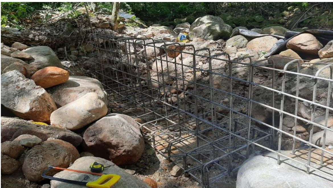
Fotografía 4. Trabajos de Mantenimiento Bocatoma.
