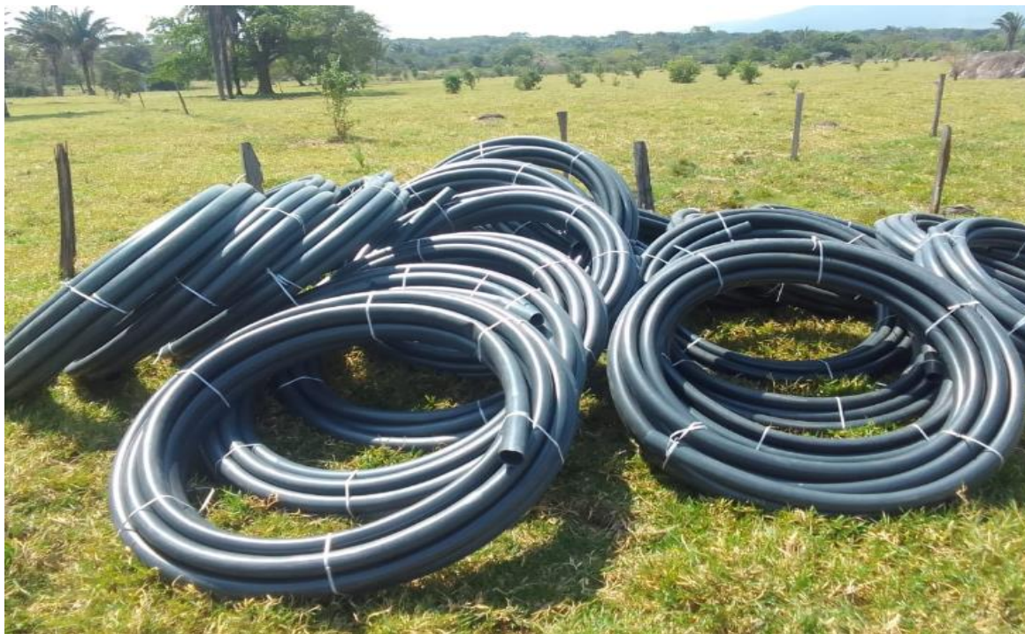
Fotografía 8. Materiales para cambio de manguera en líneas de distribución.
